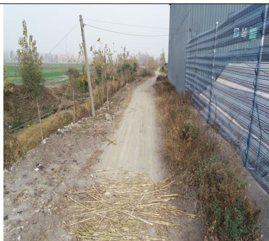
厂区西侧道路及绿化措施
