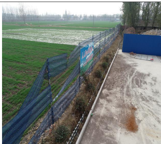
厂区东侧绿化及拦挡
