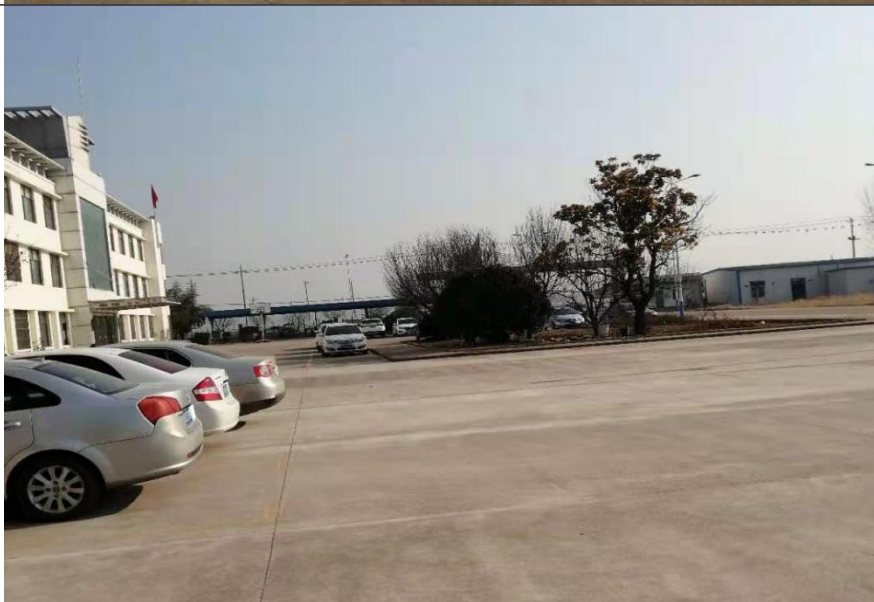
排水工程及植物措施
