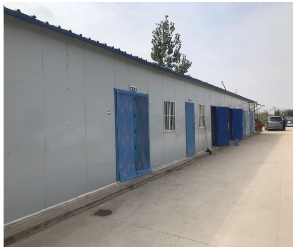
施工生产生活区
