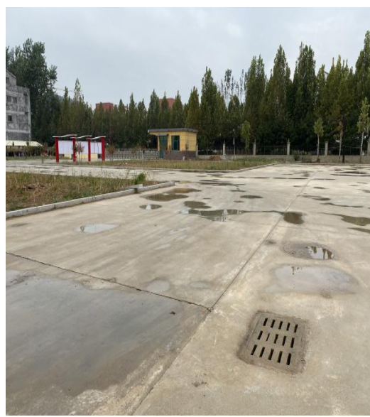
硬化路面及雨水排水
