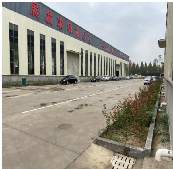
硬化路面及雨水排水
